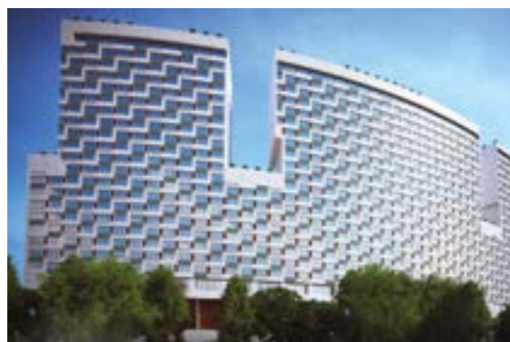
Жилой комплекс «Лица», г. Москва
